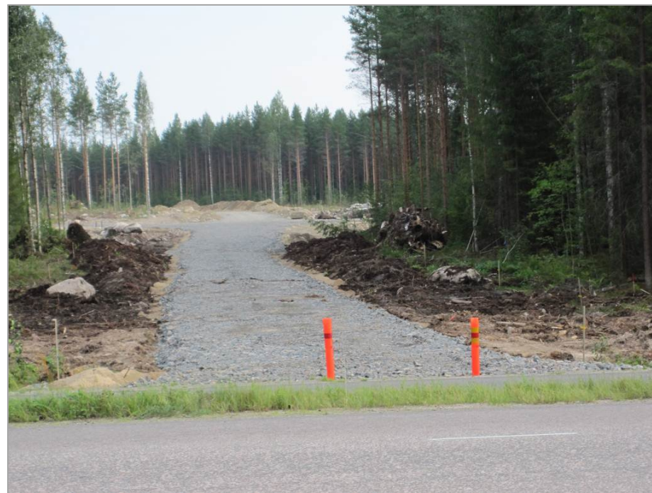
Kuva 4.15 Ähtäriin keskustan kaakkoispuolisen teollisuusalueen laajennuksen infratyöt ovat meneillään.
