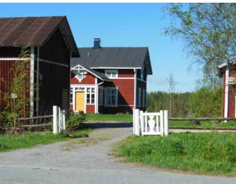
Sapsalammella on säilynyt vanhaa rakennuskantaa runsaan huvilarakentamisen ohella. (RA)
