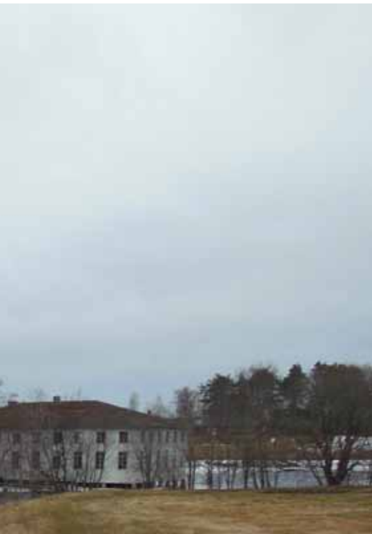
Joen päälle rakennettu vanha sähkölaitos ympäristöineen. (AK) Omgivningen kring det gamla elekticitetsverket som är byggt över ån. (AK)
