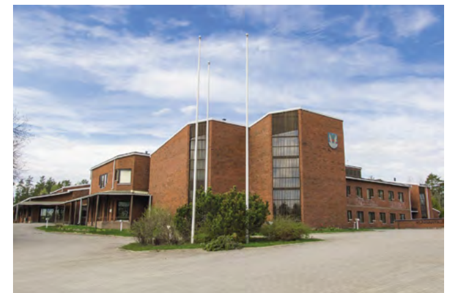
Evijärvellä rakennetaan avointa verkkoa kesän 2020 aikana muun muassa kunnantolalle sekä kirjastolle.
