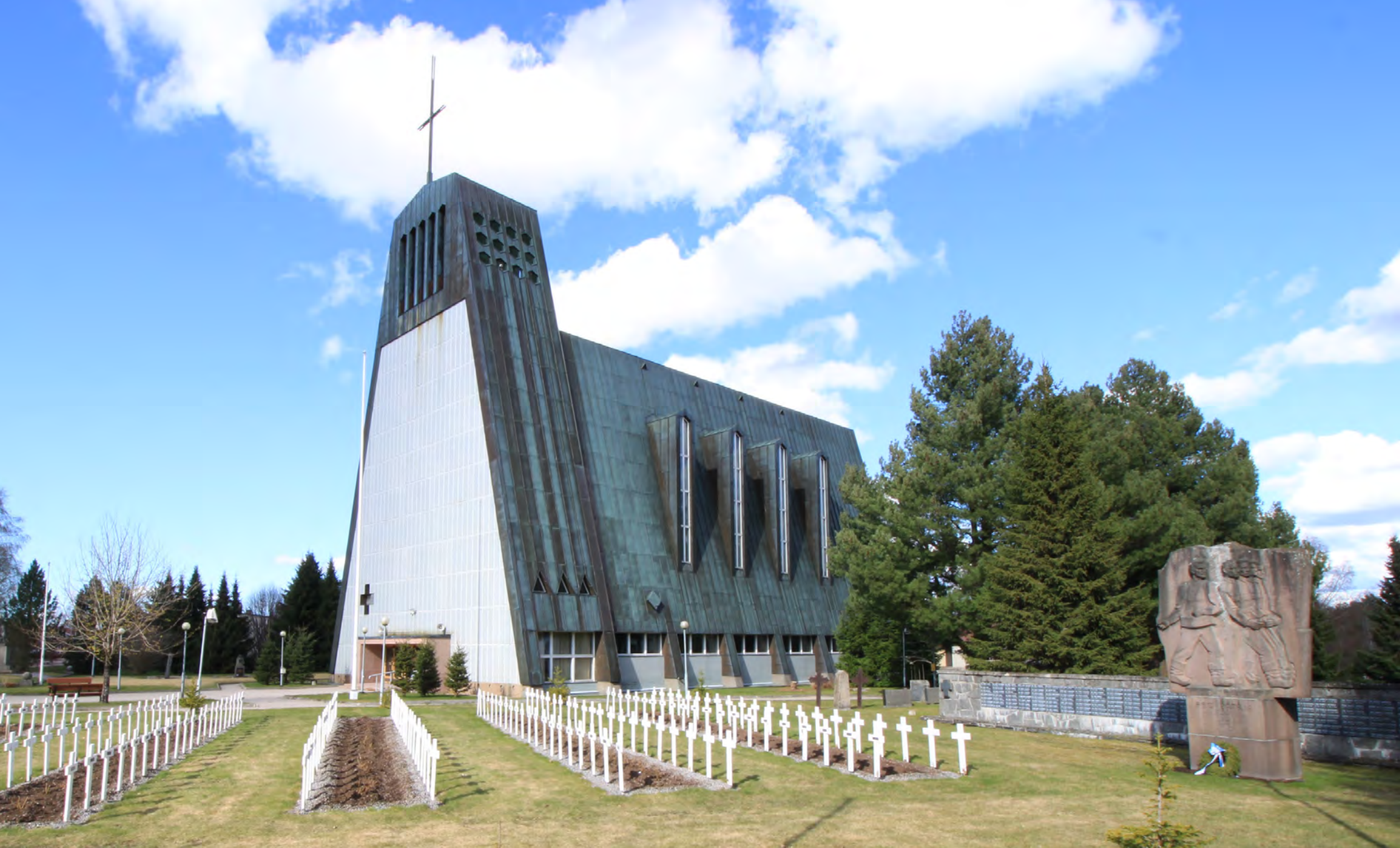
ETELÄ-POHJANMAAN MAAKUNNALLISESTI ARVOKKAAN RAKENNETUN KULTTUURIYMPÄRISTÖN ARVOTUS JA ETELÄ-POHJANMAAN UUEMMAN RAKENNETUN KULTTUURIYMPÄRISTÖN INVENTOINTI SEKÄ ARVOTUS SAATSI ARKKITEHDIT 05.03.2021
